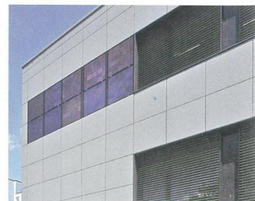
Süd-West-Fassade des Laborneubaus mit TPedge-Modulen
