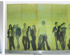
Verbundsicherheitsglas mit Fotolamination
